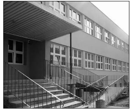
Budynek Zespołu Szkół w Bolechowie po termomodernizacji
