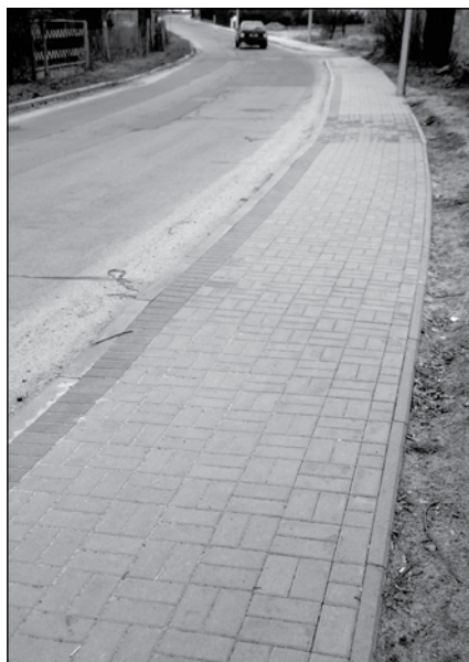
W ostatnim roku wybudowano lub wyremontowano około 20 chodników
