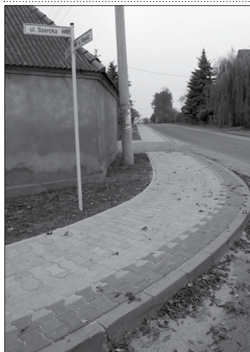
Zakończono budowę odcinka chodnika przy ul. Wiejskiej w Robakowie Wsi
