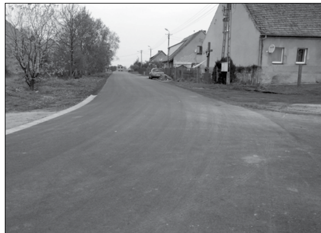
Nowy asfalt położono także na kolejnym odcinku ul. Okrężnej w Dachowie.
