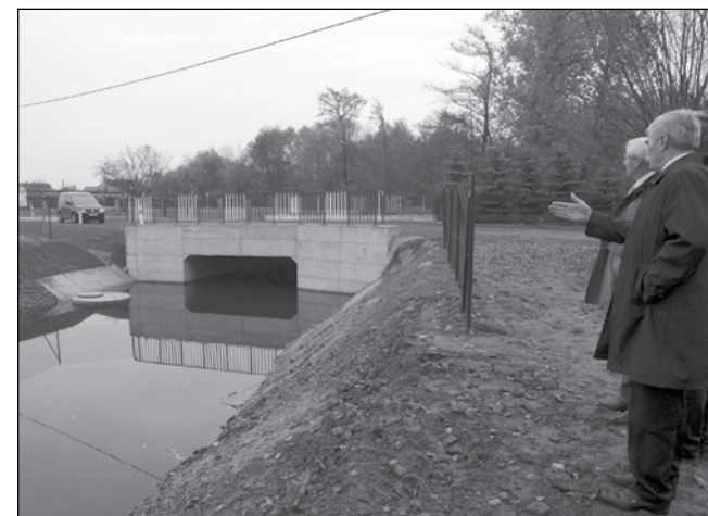
Zakończono budowę przepustu na rzece Kopli wraz z przebudową mediów przy ul. Mostowej, w miejscowości Szczytniki. Zadanie wykonała firma Zakład Usług Melioracyjnych Drenbud. Koszt zadania wraz z nadzorem i dokumentacją wyniósł 774 471, 05 zł.
