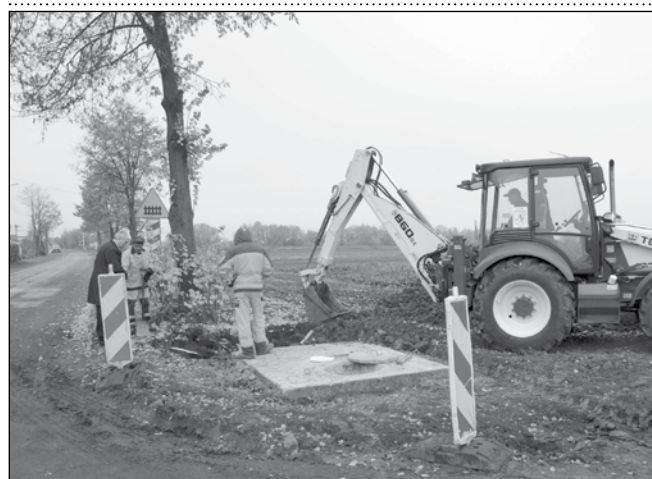
Trwają prace przy budowie magistrali wodociągowej i odcinka nowej nawierzchni w Kromolicach. Wodociąg będzie zasilany z ujęcia wody w Trzebisławkach w gminie Środa Wlkp.
