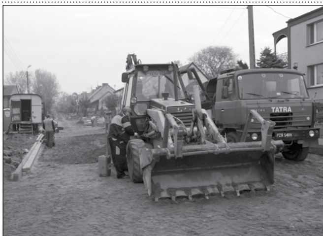
Trwają prace przy budowie magistrali wodociągowej i odcinka nowej nawierzchni w Kromolicach. Wodociąg będzie zasilany z ujęcia wody w Trzebisławkach w gminie Środa Wlkp.
