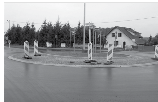
Ostatnie „kosmetyczne” prace trwają przy budowie nawierzchni ul. Poznańskiej w Borówcu, wzdłuż której wybudowano wcześniej kolektory kanalizacji sanitarnej i deszczowej
