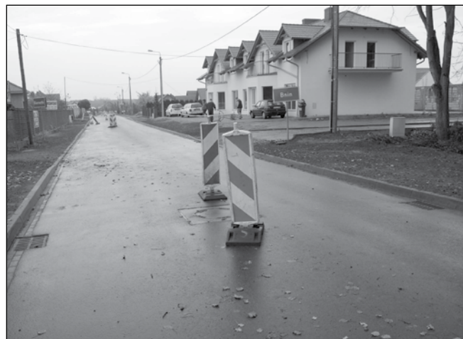
Po wybudowaniu kanalizacji deszczowej, część Alei Flensa ma już nową, asfaltową nawierzchnię.
