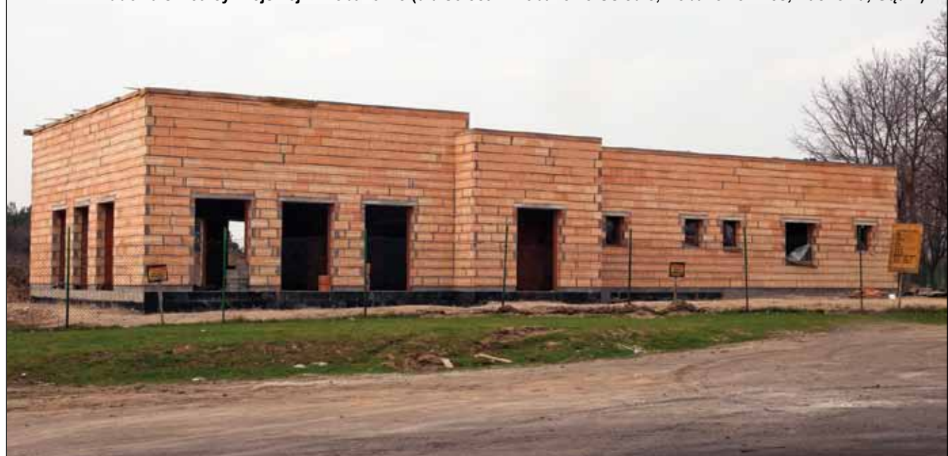
Budowa świetlicy wiejskiej w Robakowie (dla sołectw: Robakowo Osiedle, Robakowo Wieś, Dachowa, Gądko)
