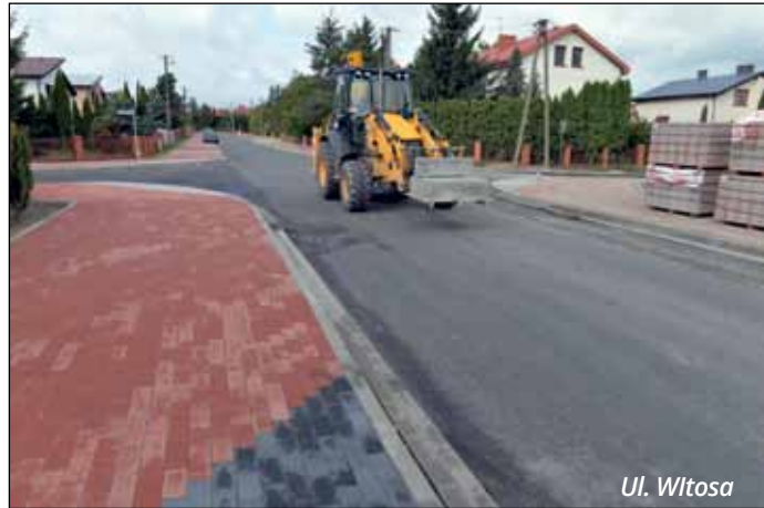
Prace na ul. Poznańskiej w Robakowie
