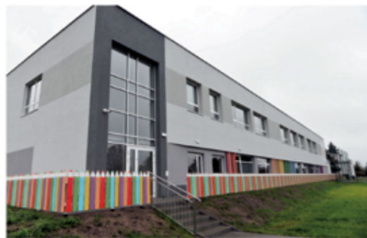
Skoła Podstawowa w Radzewie Termomodernizacja i rozbudowa Łączna kwota inwestycji: 9.199.523,56 zł
