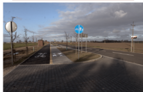
Droga powiatowa P2477 Przebudowa Łączna kwota inwestycji: niespełna 40.000.000,00 zł
