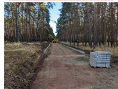
Budowa drogi w miejscowości Czmoniec Łączna kwota inwestycji: 3.845.599,40 zł
