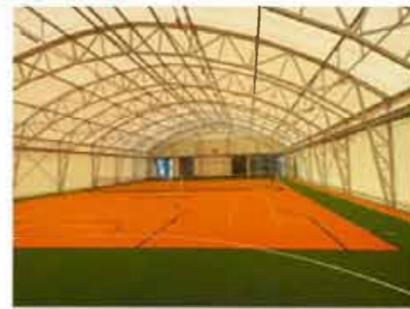
Obiekt wielofunkcyjny boisko-lodowisko na terenie Oazy-Błonie
