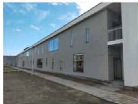
Rozbudowa Szkoły Podstawowej w Kamionkach
